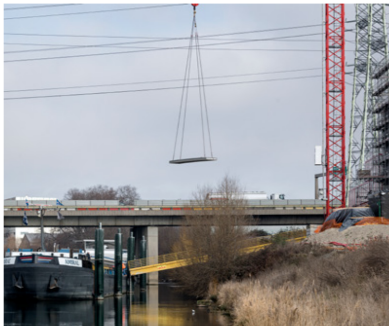
Approvisionnement fluvial, ZAC de l'écoquartier fluvial, l'Île-Saint-Denis
