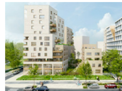
SEPTEMBRE Stains, Saint-Denis et Pierrefitte-sur-Seine
