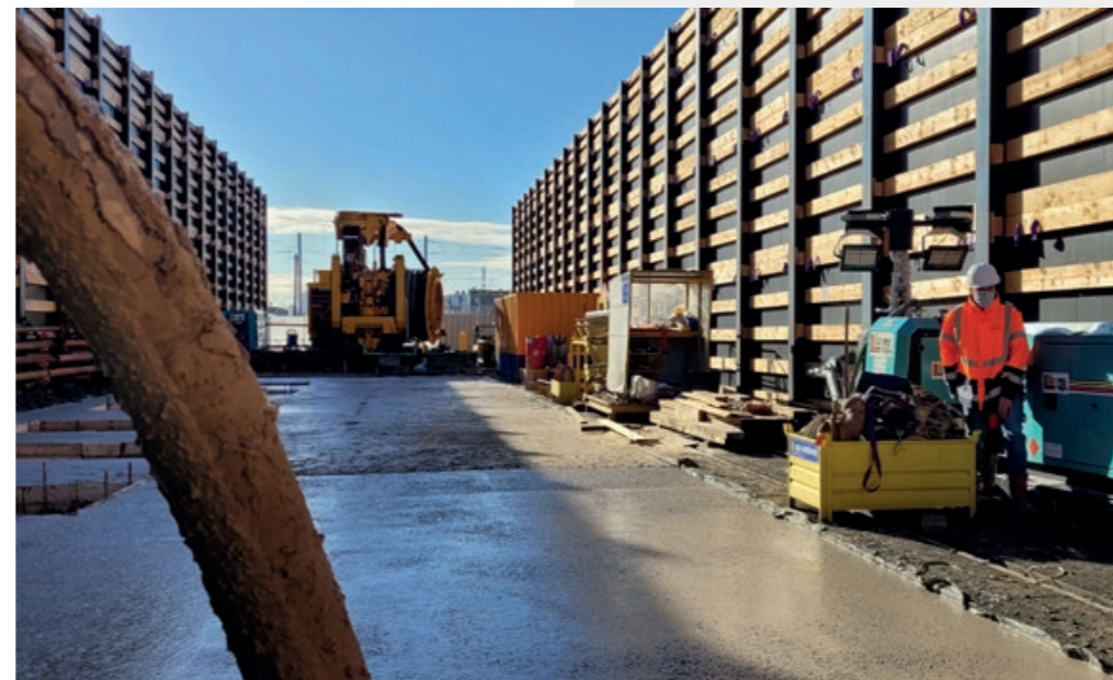
v Réalisation de la dalle de propreté et murettes guides pour la réalisation des appuis P2 - octobre 2021
